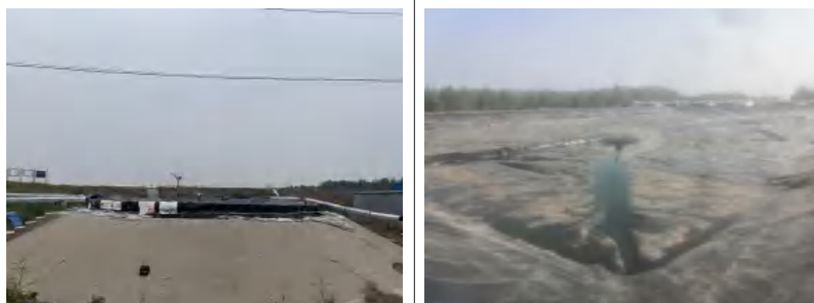
图 3.1-3 废水收集池、黑膜沼气池
